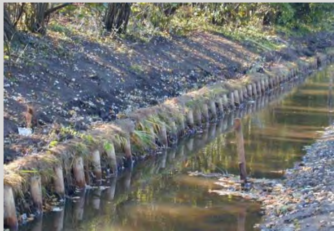
Photo 51 : Exemple d'installation des fascines par maintien par pieux
